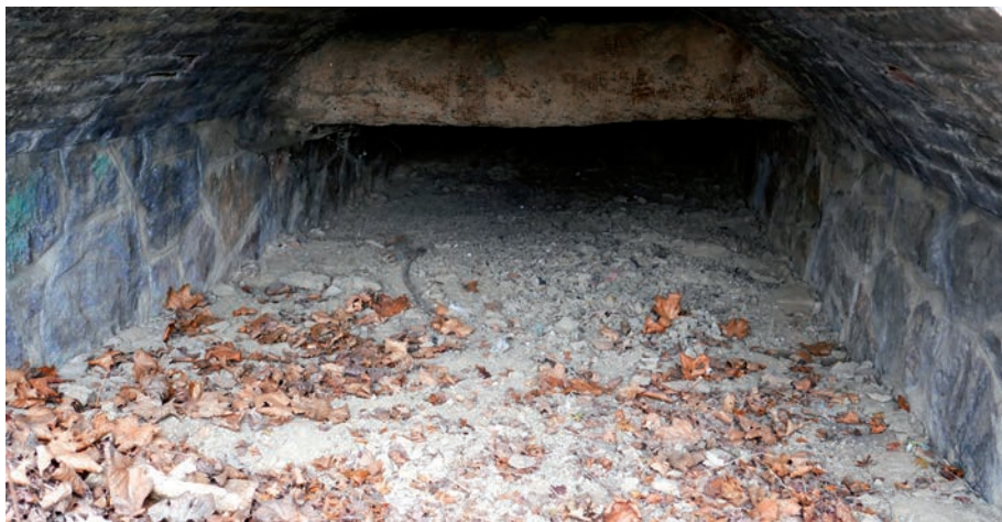
Obr. 39 Propustek pod železnicí a silnicí ústící do starého přístavu v Praze-Libni (GPS: N 50°6.808', E 14°27.496'). Propustek neplní svoji funkci, je dlouhodobě suchý, a proto jsou v něm dosud uloženy povodňové kaly z roku 2002 a 2013 [foto R. Mikuláš, 2018]
