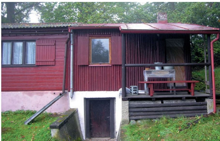
Obr. 28 Omítka kameno-betonových základů stavby provedená pískem z těles vyobrazených na obr. 14 [foto R. Mikuláš, 2012]
